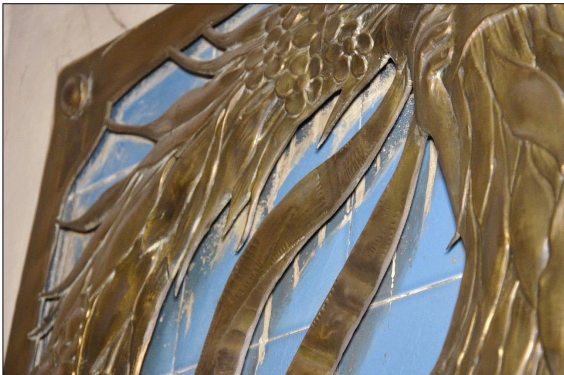
Současný stav a ukázky poškození keramických obkladů stěn předsálí dole: keramický obklad pod mosaznými mřížkami na stěnách Oktogonálního salonku
