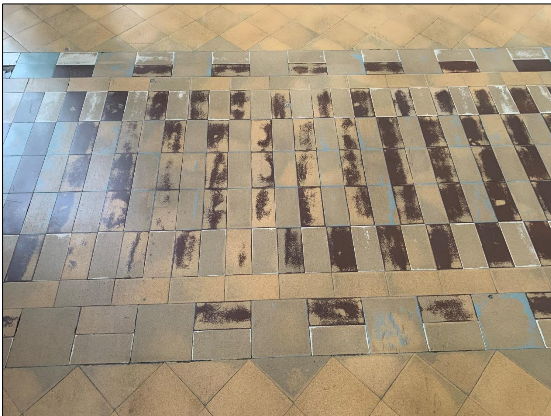
Detail stavu opotřebení dlažby v chodbě
