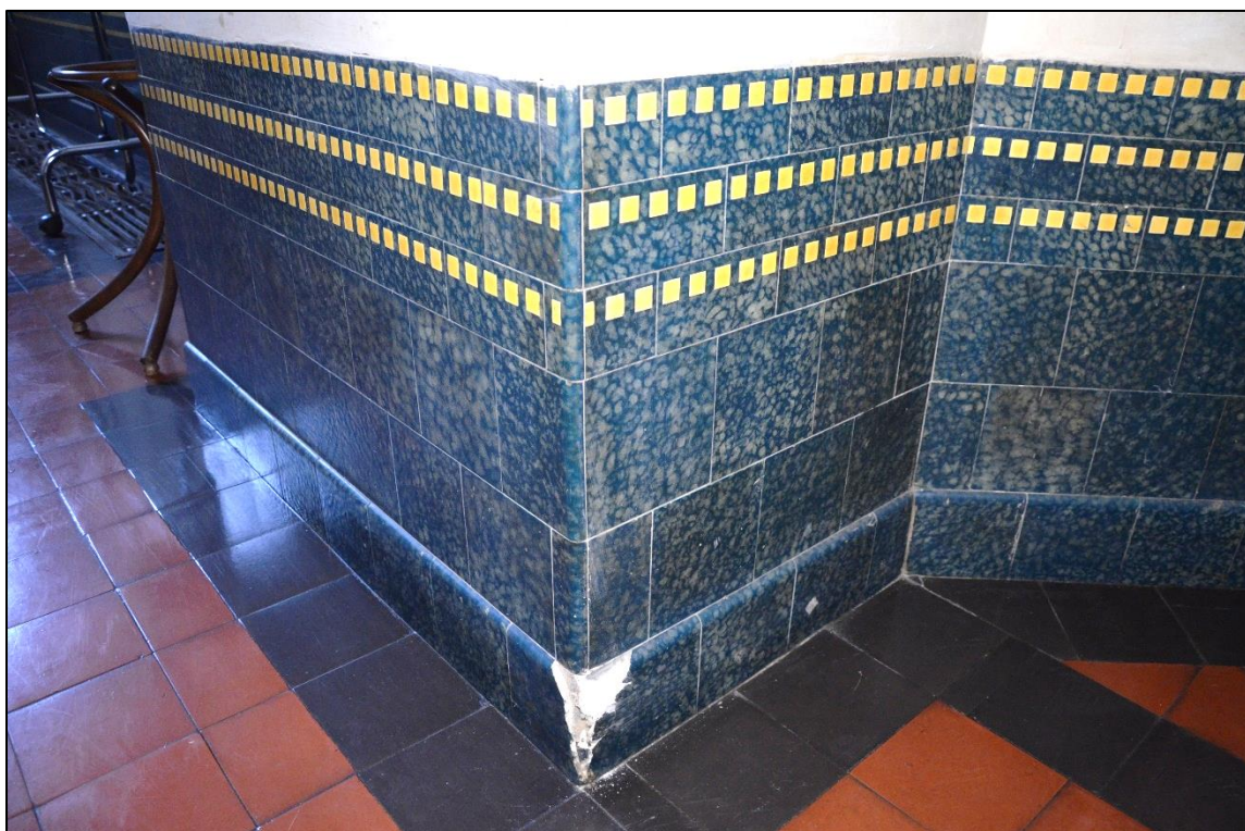
Současný stav a ukázky poškození keramických obkladů stěn předsálí
