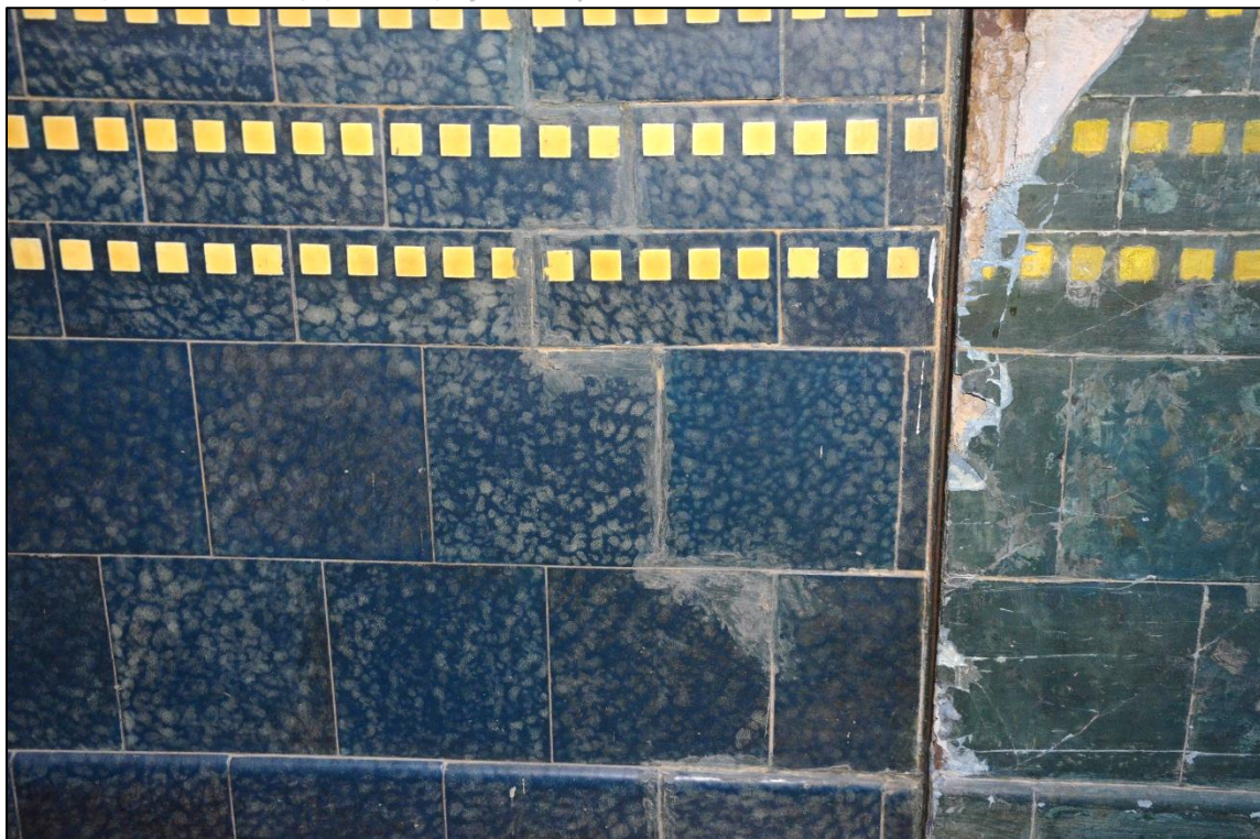
Současný stav a ukázky poškození keramických obkladů stěn předsálí dole: keramický obklad pod mosaznými mřížkami na stěnách Oktogonálního salonku
