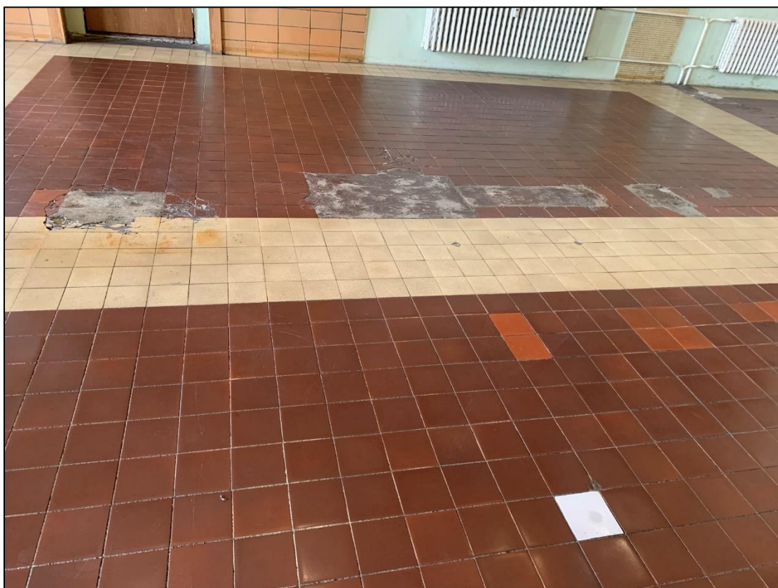
Bližší snímky poškození dlažby bývalé Příjezdové haly a chodby
